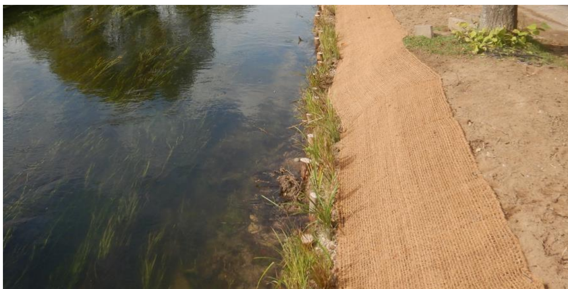
Exemple de berge restaurée en génie végétal à Senlis (Rue St-Etienne)
